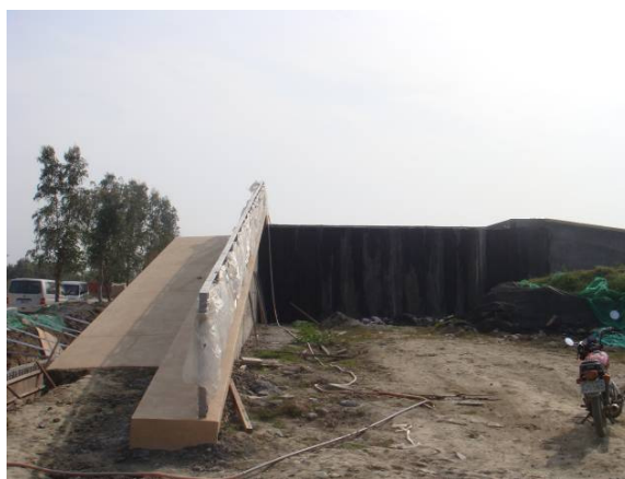
100.03.01 側面圖(C棟)
