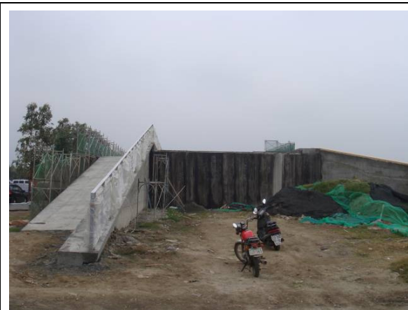
100.02.14 側面圖(C棟)
