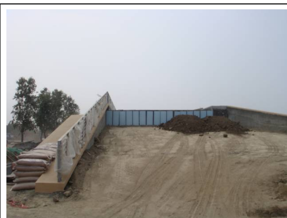
100.03.14 側面圖(C棟)
