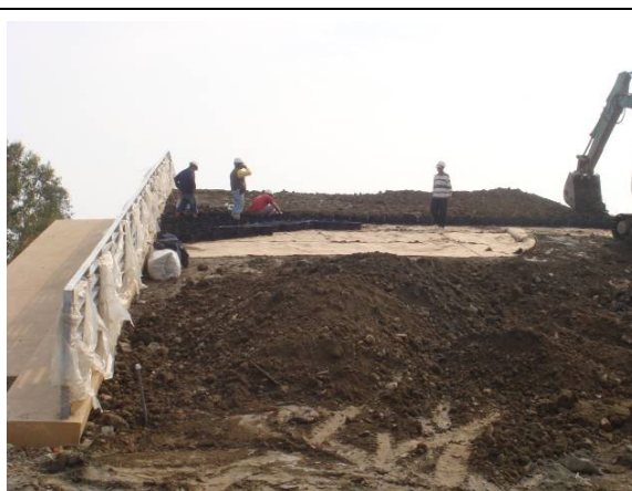
100.03.28 側面圖(C棟)
