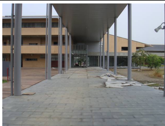
100.08.01 A、B棟內部銜接長廊
