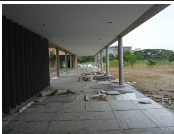
100.08.01 A、B棟內部銜接長廊
