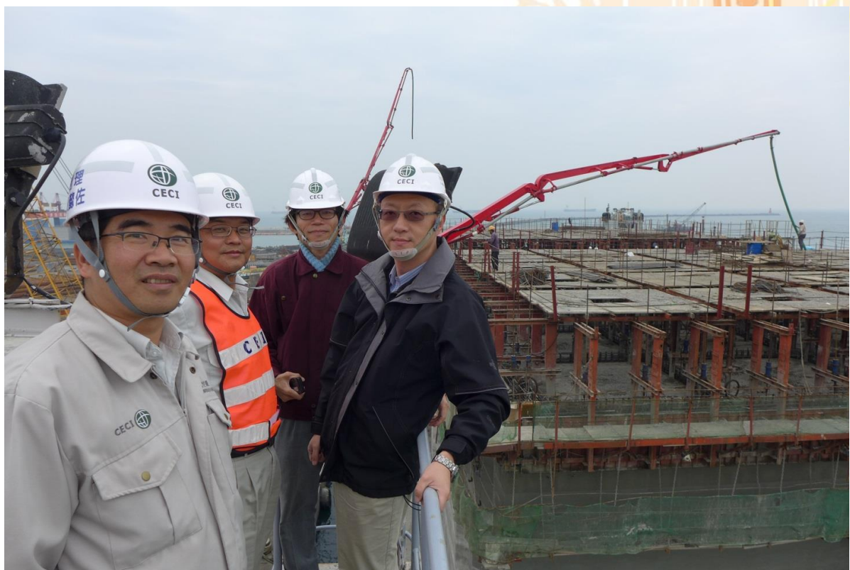
與台灣世曦高辦處陳副理、洲際二期計畫謝經理及俞肇球老師合影於洲際二期工地的浮台船上，背景為船上利用滑模正在建造中的沉箱。
