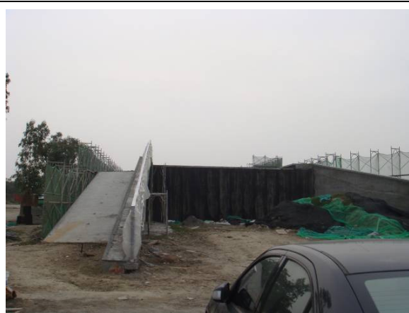
100.01.10 側面圖(C棟)
