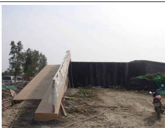
100.03.01 側面圖(C棟)
