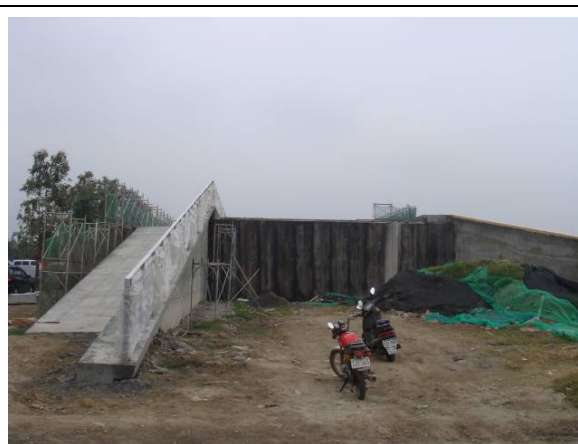
100.02.14 側面圖(C棟)
