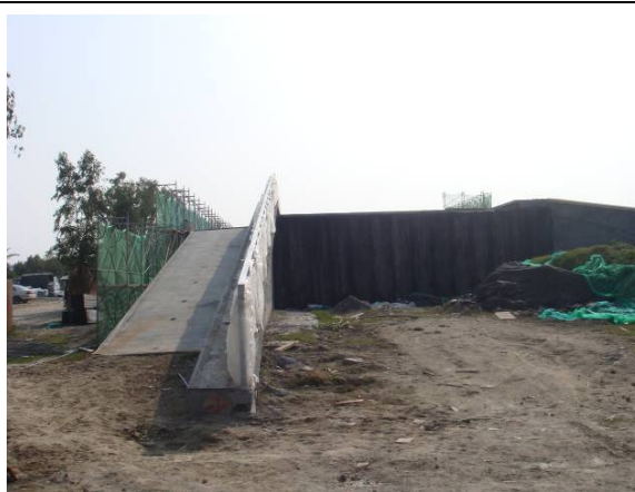
100.01.24 側面圖(C棟)
