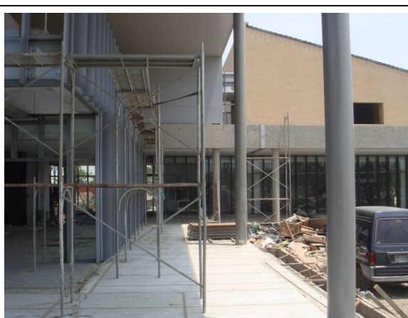
100.04.25 A、B棟內部銜接長廊
