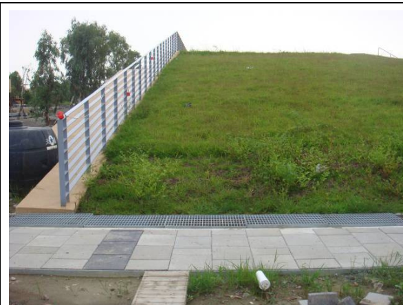
100.08.01 側面圖(C棟)
