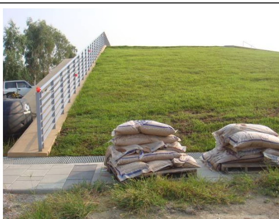
100.09.26 側面圖(C棟)
