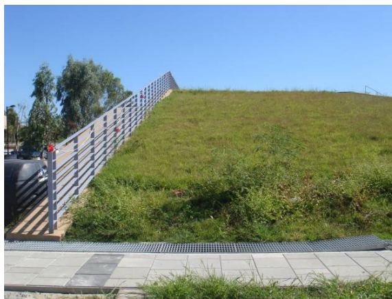
100.08.17 側面圖(C棟)
