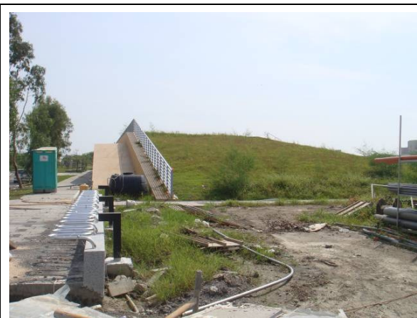
100.09.13 側面圖(C棟)
